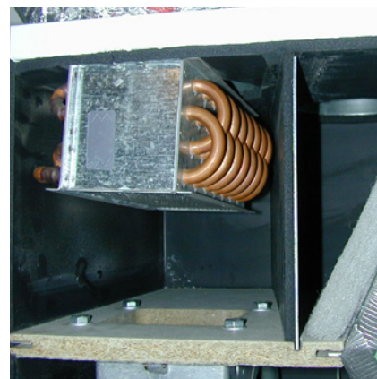
Das Heizregister im Lüftungsgerät überträgt die Wärme der Heizungsanlage an die Zuluft.
