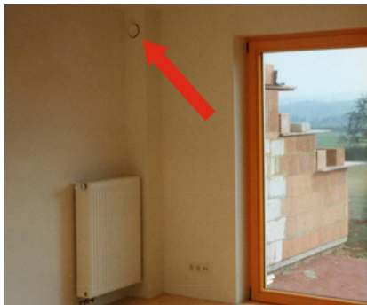
Zuluftventil über einem Heizkörper
