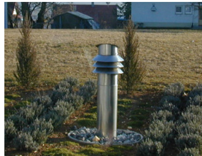
Frischluftansaugung am Ende eines Erdreichwärmetauschers
