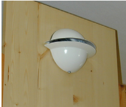
Zuluftventil in Form einer „Weitwurf-düse“; hier eingebaut in ein Regal.
